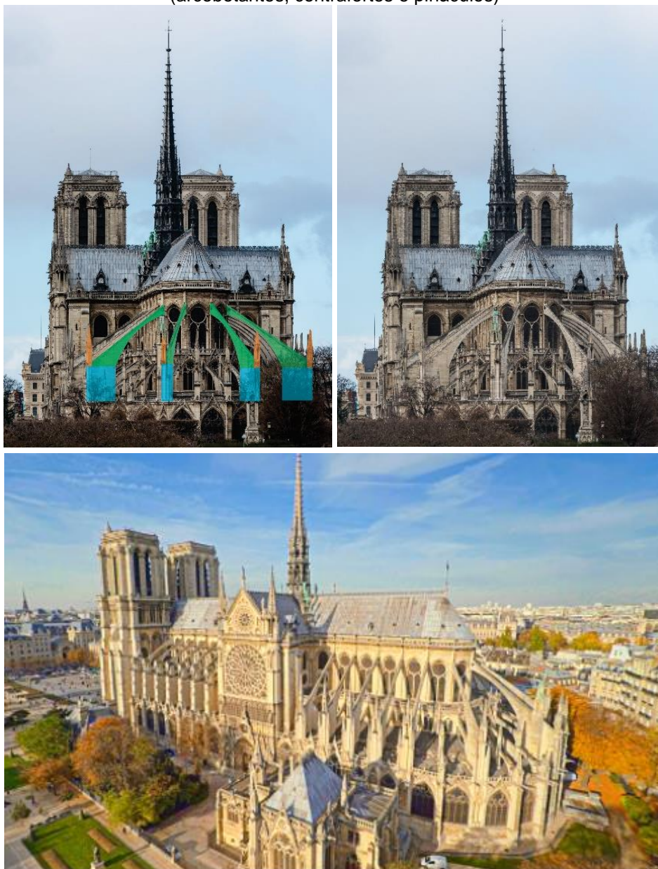
Figura 12 – Parte do sistema estrutural da Catedral de Notre Dame de Paris . (arcobotantes, contrafortes e pináculos)
